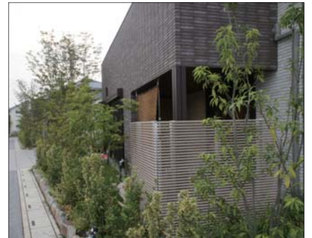
写真3 クールルーバーを設置した住宅
